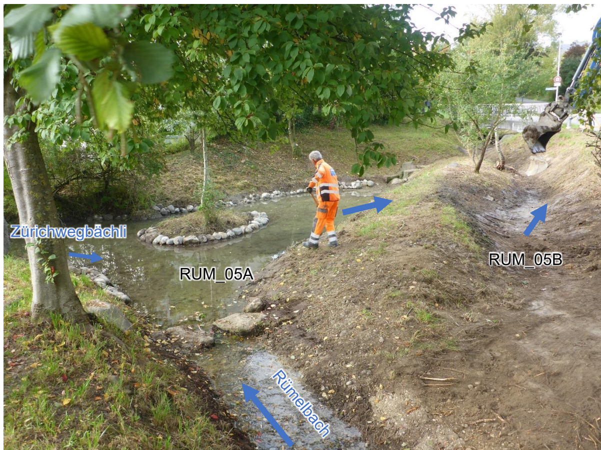
Abb. 8: Übersicht der Gewässerverzweigung am Rümelbach im Bereich der Mündung des Zürichwegbächlis.
